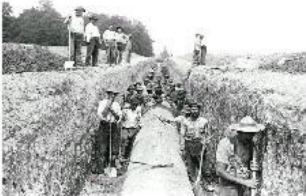
Conduit construction 1890's
